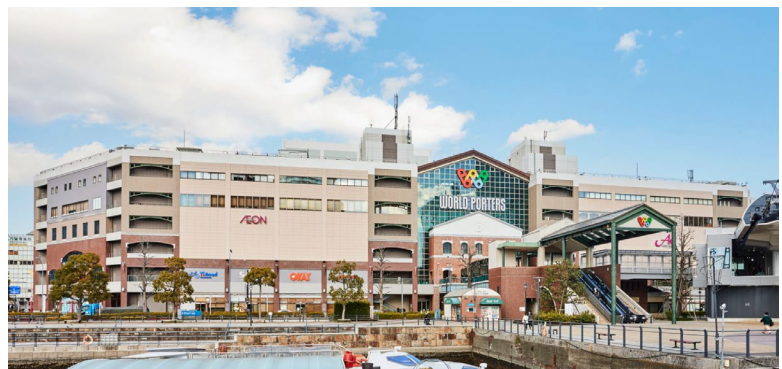
横浜ワールドポーターズ外観写真
