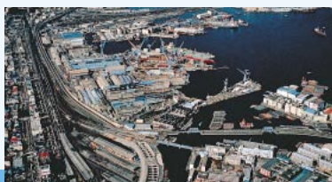
着工前のみなとみらい21地区 (1980(昭和55)年)
