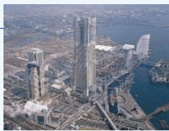
着々と進む施設建設 (1994 (平成6) 年)
