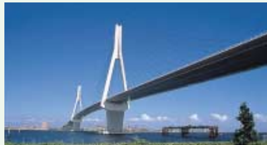
鶴見つばさ橋 橋長1,020 m、上下6車線
