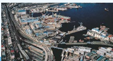
着工前のみなとみらい21地区(1980(昭和55)年)
