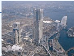
着々と進む施設建設(1994(平成6)年)
