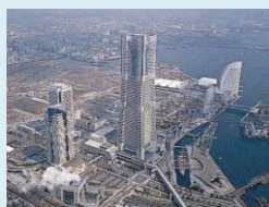
着々と進む施設建設(1994(平成6)年)
