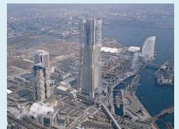
着々と進む施設建設(1994(平成6)年)
