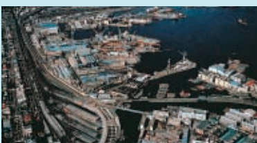
着工前のみなとみらい21地区(1980(昭和55)年)
