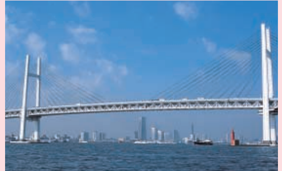
横浜ベイブリッジ 橋長860m 上下2層構造
