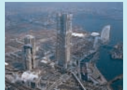
着々と進む施設建設(1994(平成6)年)
