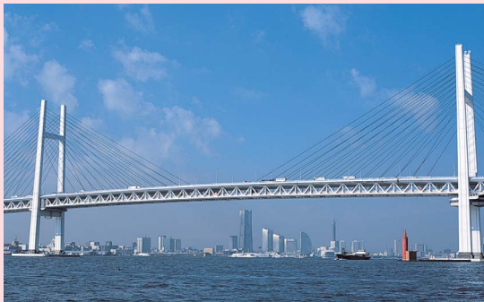
横浜ベイブリッジ 橋長860m 上下2層構造
