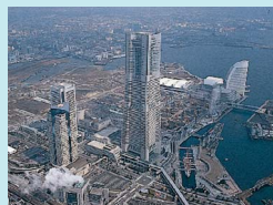
着々と進む施設建設（1994（平成6）年）
