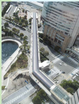
動く歩道屋根ソーラーパネル
