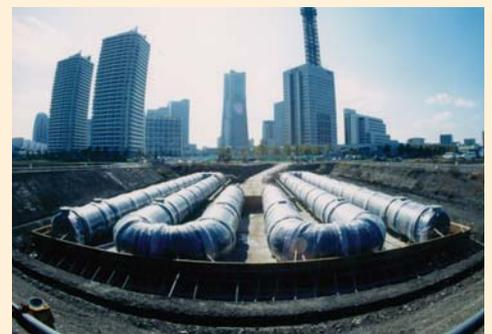
現況 … 1993(平成5)年ヨ-ヨ-広場地下に1,000㎡、1994(平成6)年臨港パーク地下に700㎡、2000(平成12)年新港パーク地下に1,300㎡、2005(平成17)年高島中央公園地下に1,500㎡の災害用地下給水タンクが完成しました。
