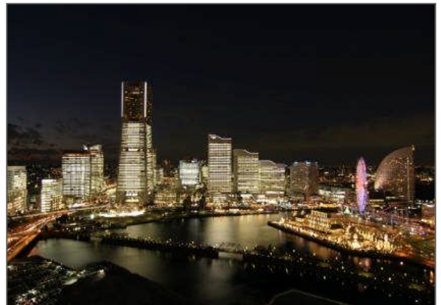
<TOWERS Milight ～オフィス全館ライトアップ～ >
