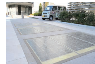
路面太陽光発電 (みなとみらい21熱供給センタープラント)
