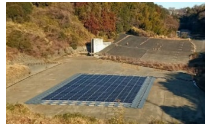
<湘南桂台雨水調整池>
